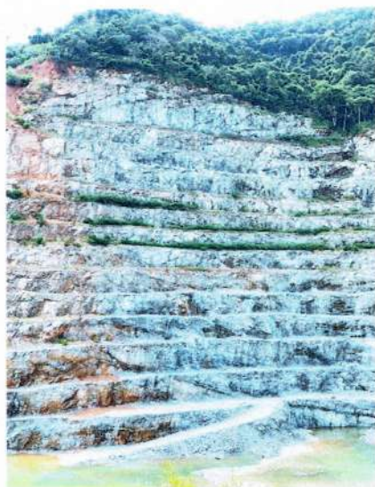
รูปที่ 3 ปลุกต้นไม้บริเวณหน้าเหมือง โดย ปลุกที่ชั้นบันได (Bench) ระดับที่ 30, 40, 50, 60, 70, 100, 110 และ 120 MSL
