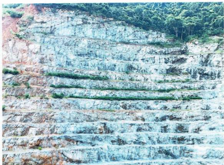
รูปที่ 3 ปลุกต้นไม้บริเวณหน้าเหมือง โดย ปลุกที่ชั้นบันได (Bench) ระดับที่ 30, 40, 50, 60, 70, 100, 110 และ 120 MSL
